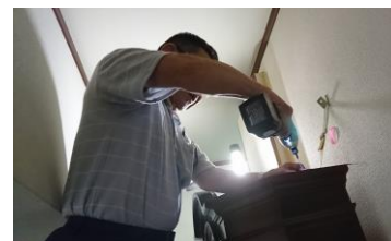
耐震留具取付作業の様子
