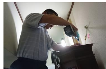
耐震留具取付作業の様子
