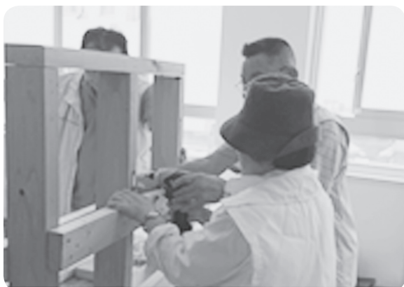
家具固定金具取り付け体験 窓ガラスフィルム貼り体験
